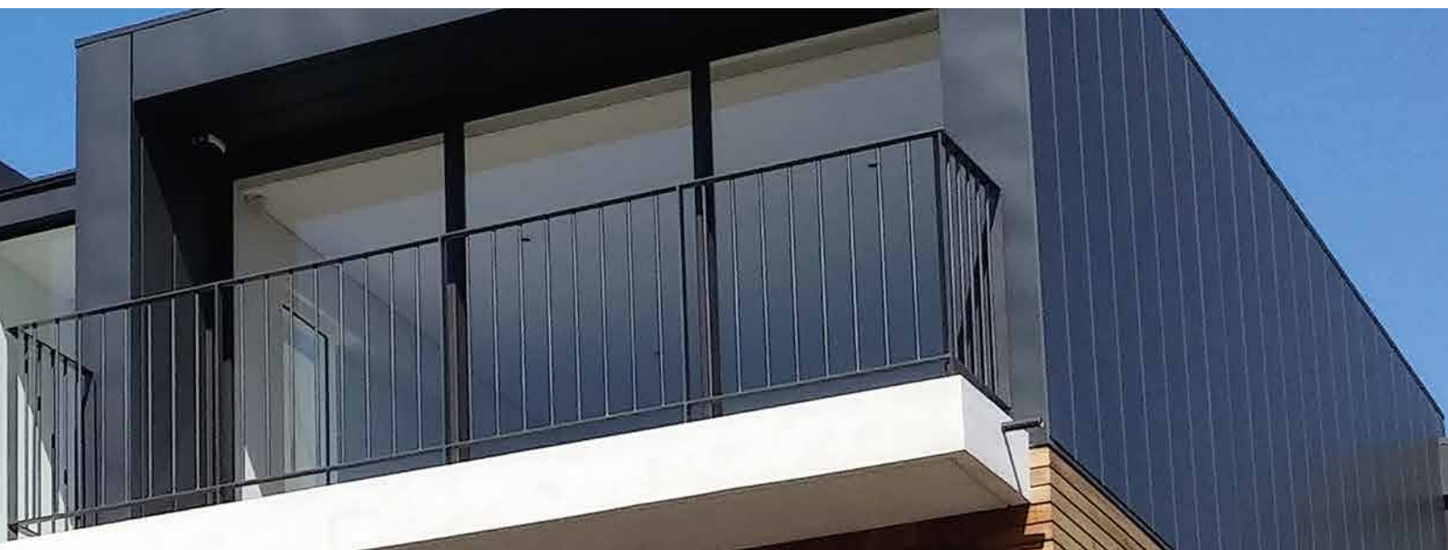
Edificio multifamiliar, Australia SJB
